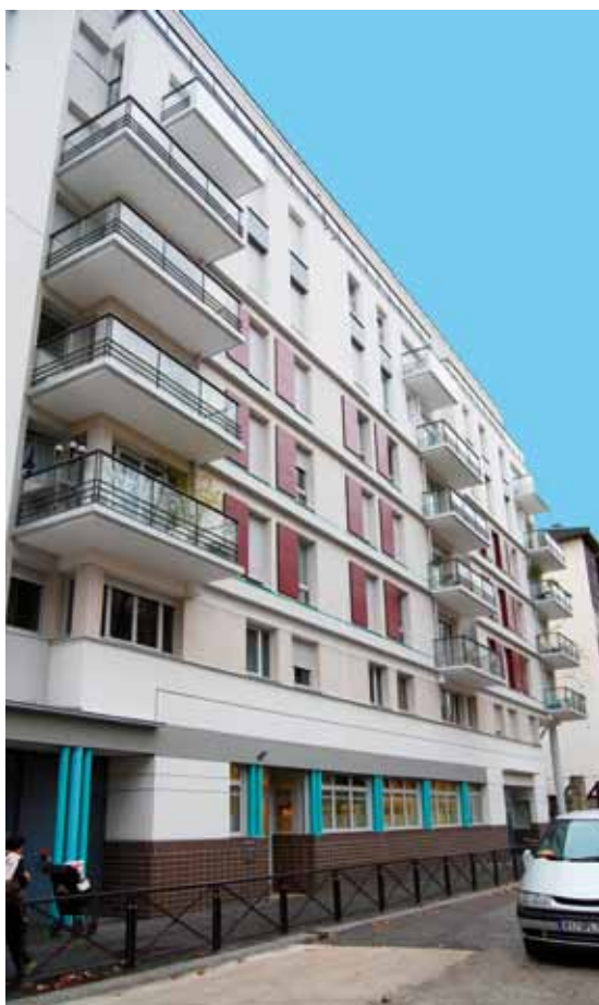
Строительный объект в Париже
